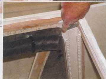
La mise en place des gaines à l'aide de colliers (ci-dessus) et de goulottes (ci-contre) est le préalable obligatoire à l'installation du câblage électrique.
