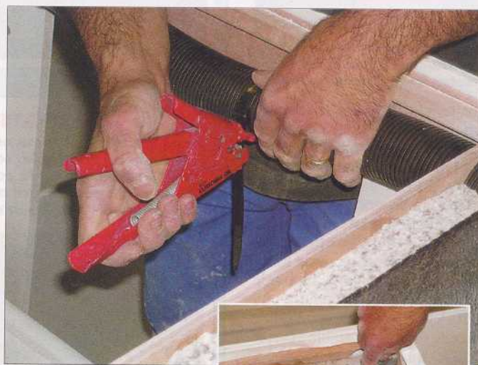
La mise en place des gaines à l'aide de colliers (ci-dessus) et de goulottes (ci-contre) est le préalable obligatoire à l'installation du câblage électrique.
