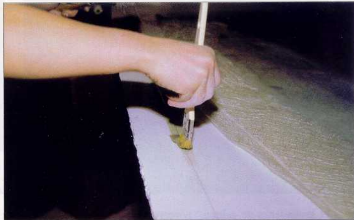
Le pinceau est utilisé pour s'assurer de la présence de résine dans les angles, comme ici au niveau du livet de pont.
