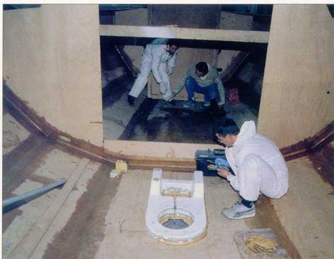
La mise en place de la chaise moteur qui supporte le Sail-Drive intervient avant la pose de la structure.
