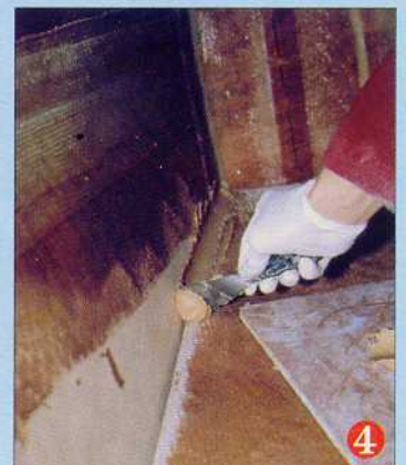
L'époxy est appliqué, en faisant bien attention de ne pas laisser de vides. Puis on repasse une spatule aux bords arrondis en lissant. Les irrégularités seront poncées pour la finition.
