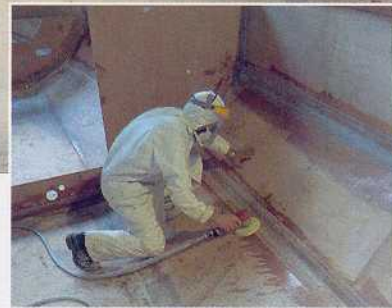
Après 24 heures de séchage, toutes les bandes de stratification sont légèrement poncées.
