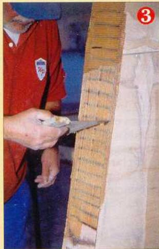
La pièce de lamellé-collé est ensuite enduite de colle époxy à l'aide d'une raclette crantée.
